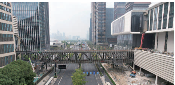
杭州国际博览中心二期项目目前全面进入竣工收尾阶段,完工后一期、二期项目将实现“珠联璧合”。图为连接一期、二期的双层空中连廊。 记者 范方斌 摄
