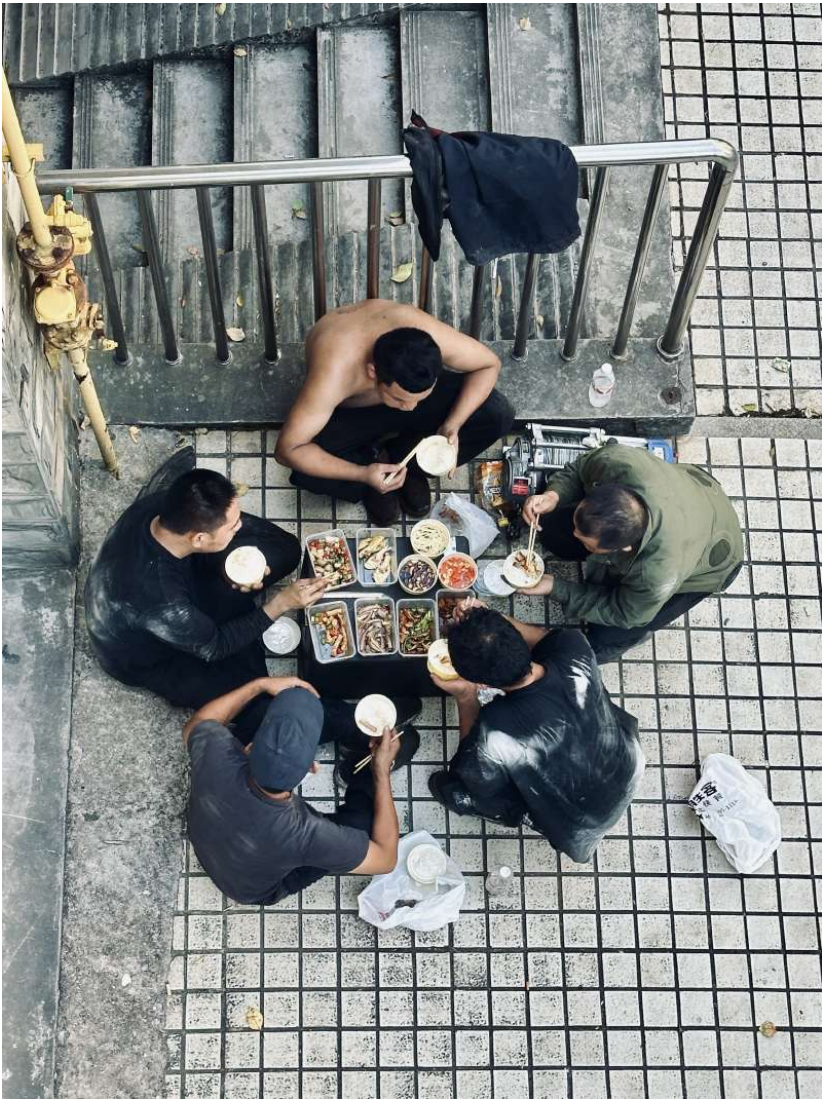
@望辰阁主 致敬高温下的劳动者 烈日炎炎,工人在给小区安装新电梯,午休的时间,他们聚在一起,一起流汗一起吃饭一起聊天。
