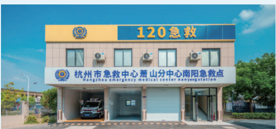
杭州市急救中心萧山分中心南阳急救点
